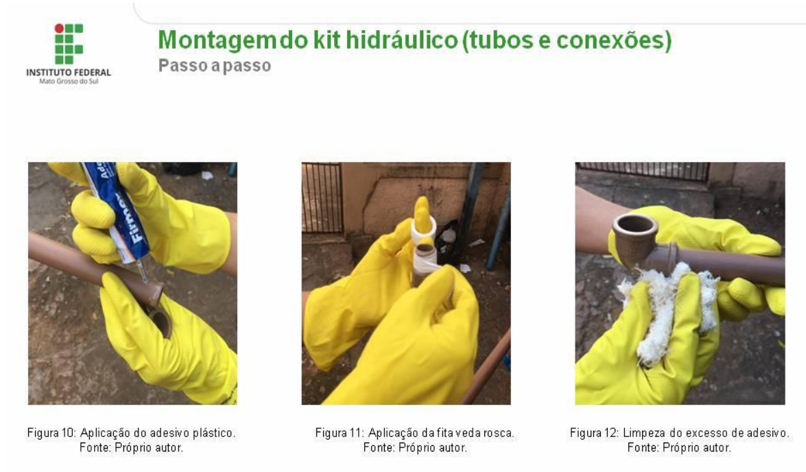
Figura 17 – Etapa executiva de solda de tubos e conexões apresentada pelos estudantes em videoconferência
