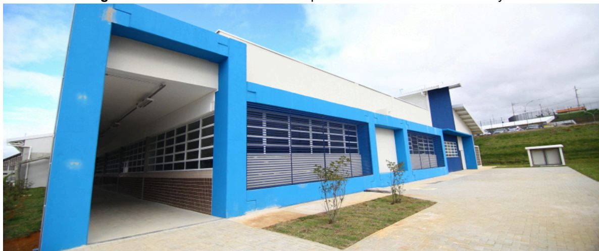
Figura 2 - Fachada da Escola Municipal Maria Antonieta Ferreira Payar.
