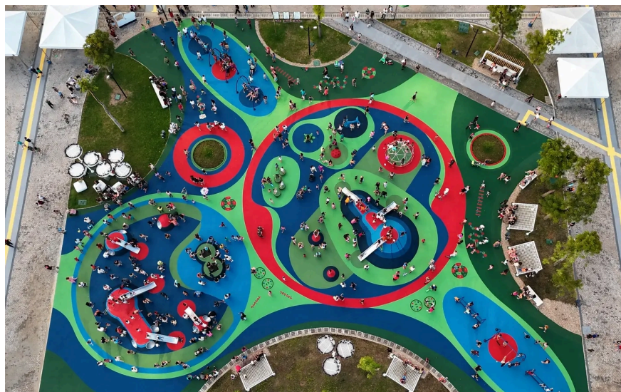
Figura 34 a 39. Parque infantil com piso emborrachado; Mobiliário Urbano, paisagismo e drenagem; Lago ornamental; Mobiliário urbano; Parque aquático infantil; Vista aérea de parte do parque;
