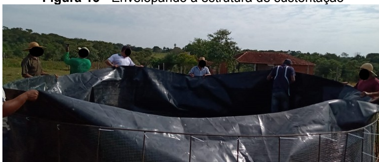
Figura 13 - Envelopando a estrutura de sustentação
