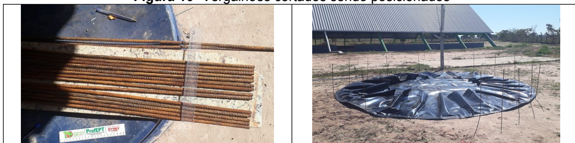
Figura 10- Vergalhões cortados sendo posicionados
