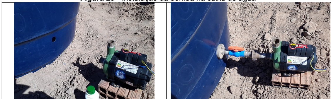
Figura 29 - Instalação da bomba na caixa de água
