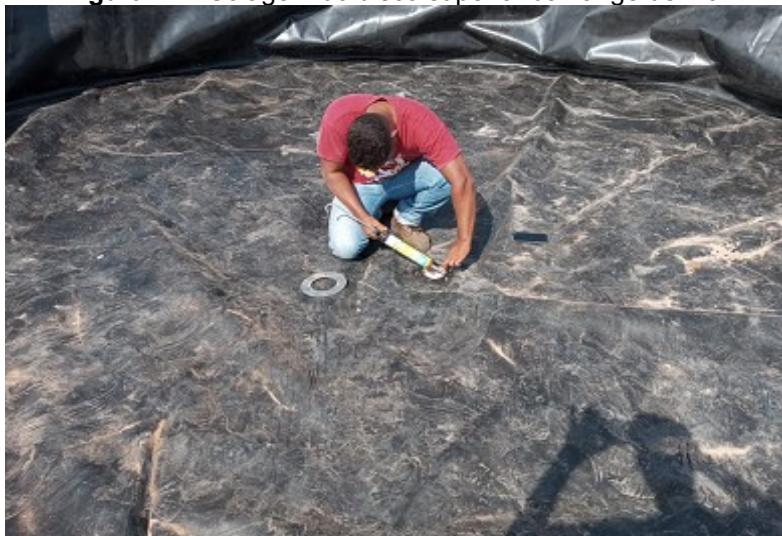
Figura 17- Colagem do disco superior da flange de inox
