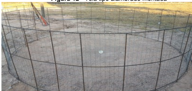
Figura 12 - Tela tipo alambrado montada
