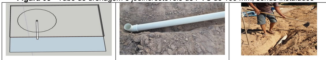
Figura 08 - Tubo de drenagem e joelho/cotovelo de PVC de 100 mm, sendo instalados
