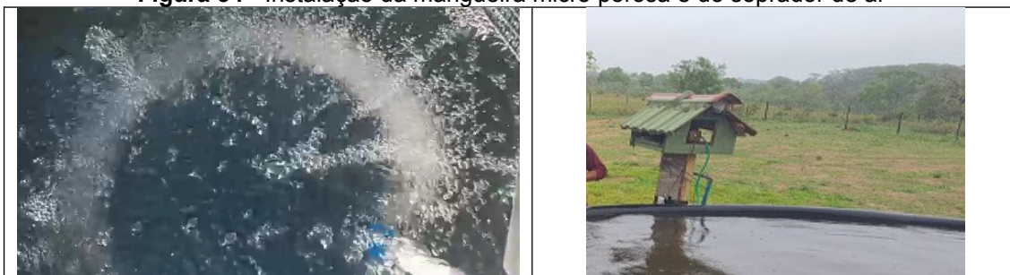
Figura 34 - Instalação da mangueira micro porosa e do soprador de ar
