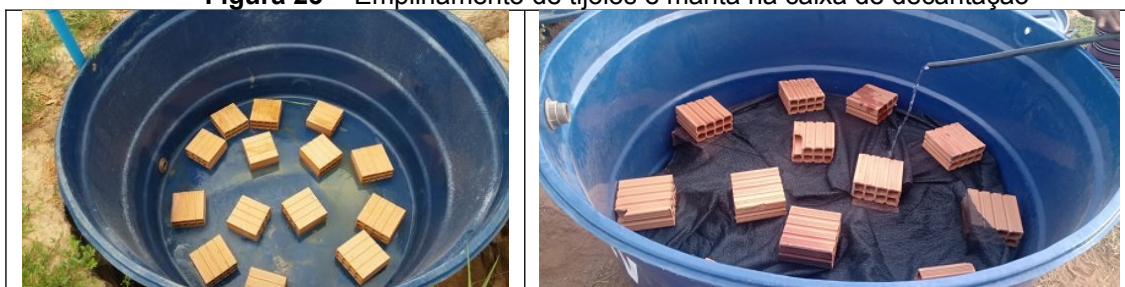
Figura 23 - Empilhamento de tijolos e manta na caixa de decantação
