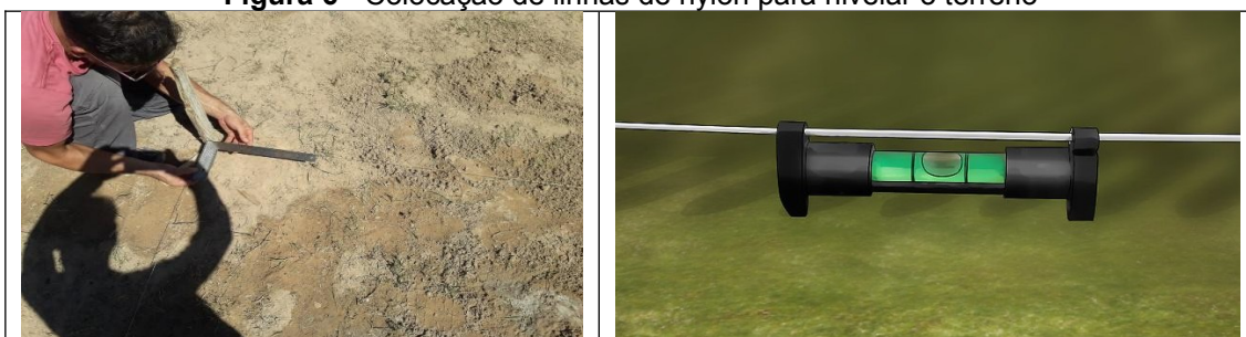
Figura 6 - Colocação de linhas de nylon para nivelar o terreno
