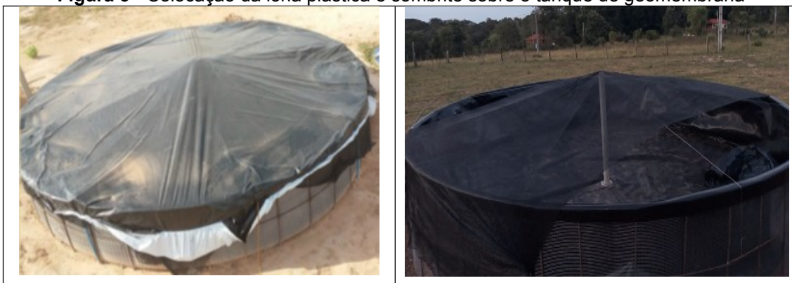
Figura 3 - Colocação da lona plástica e sombrite sobre o tanque de geomembrana
