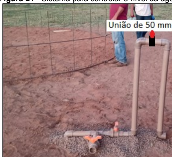
Figura 21 - Sistema para controlar o nível da água
