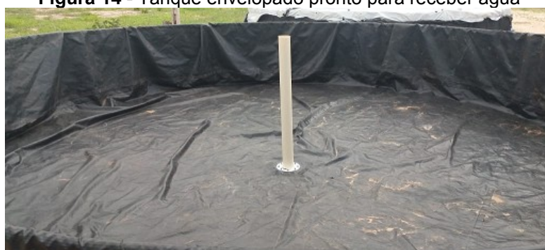
Figura 14 - Tanque envelopado pronto para receber água
