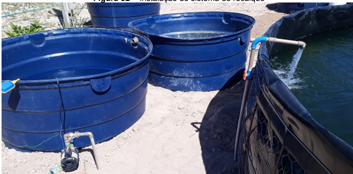
Figura 32 - Instalação do sistema de recalque
