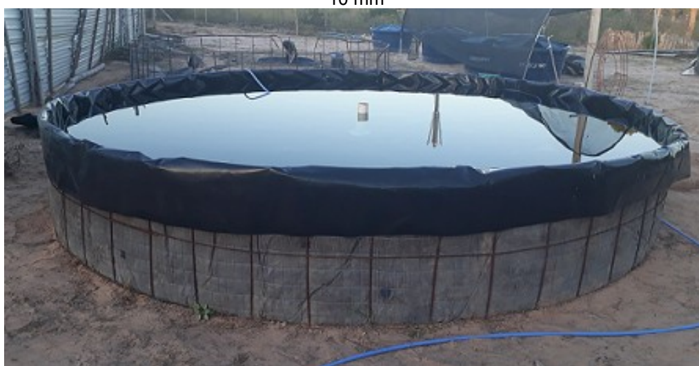
Figura 1 - Tanque de geomembrana de 30 m 3 com a estrutura de suporte construído com vergalhão de 10 mm
