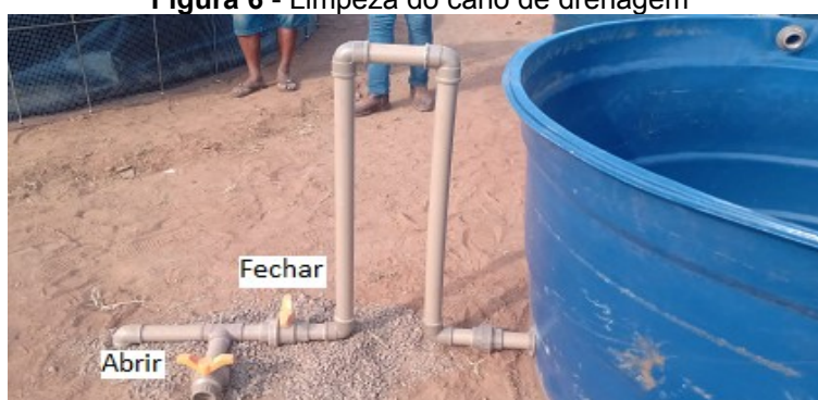
Figura 6 - Limpeza do cano de drenagem
