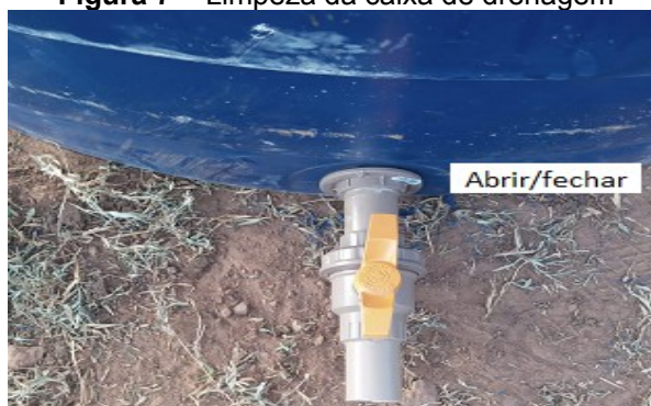
Figura 7 - Limpeza da caixa de drenagem
