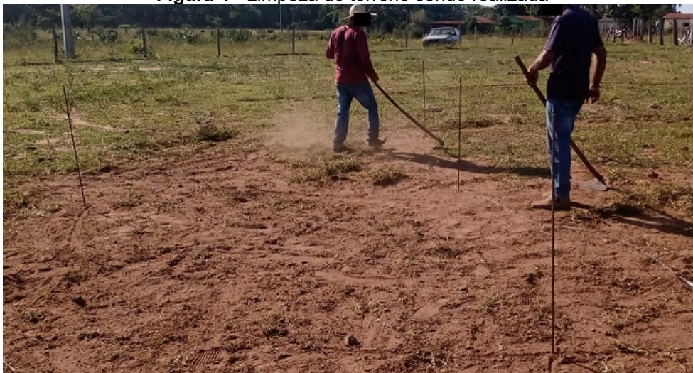
Figura 4 - Limpeza do terreno sendo realizada
