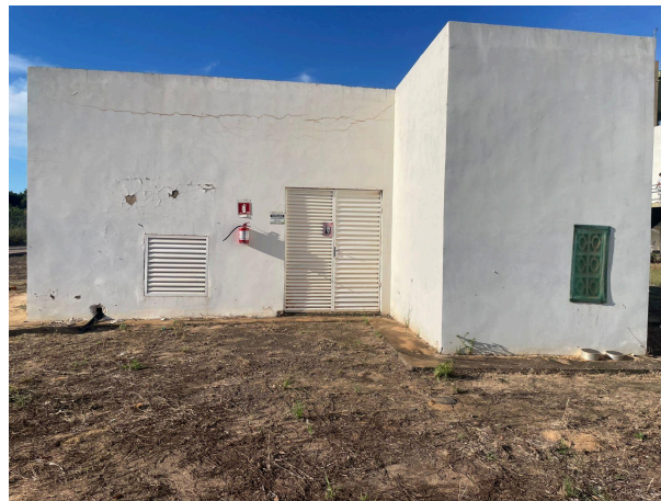
Figura 6 - Subestação abrigada, IFMS campus Três Lagoas.
