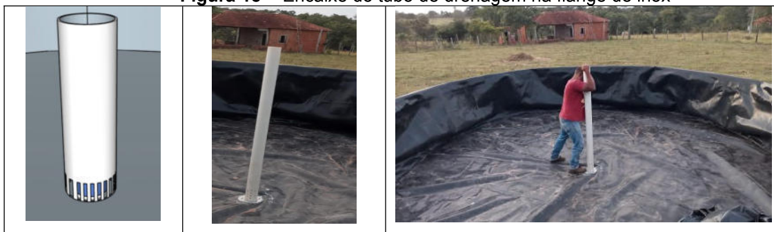
Figura 18 - Encaixe do tubo de drenagem na flange de inox
