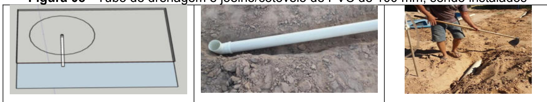
Figura 08 - Tubo de drenagem e joelho/cotovelo de PVC de 100 mm, sendo instalados
