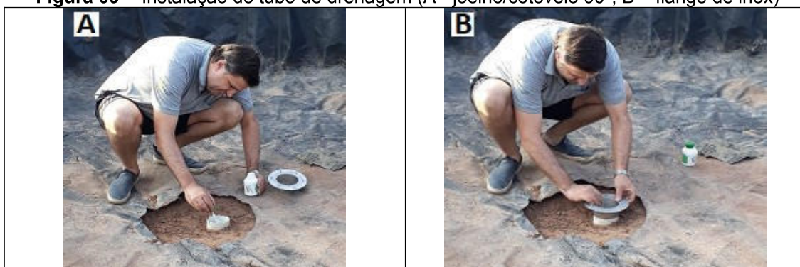
Figura 09 - Instalação do tubo de drenagem (A - joelho/cotovelo 90°, B – flange de inox)
