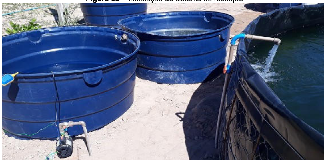
Figura 32 - Instalação do sistema de recalque
