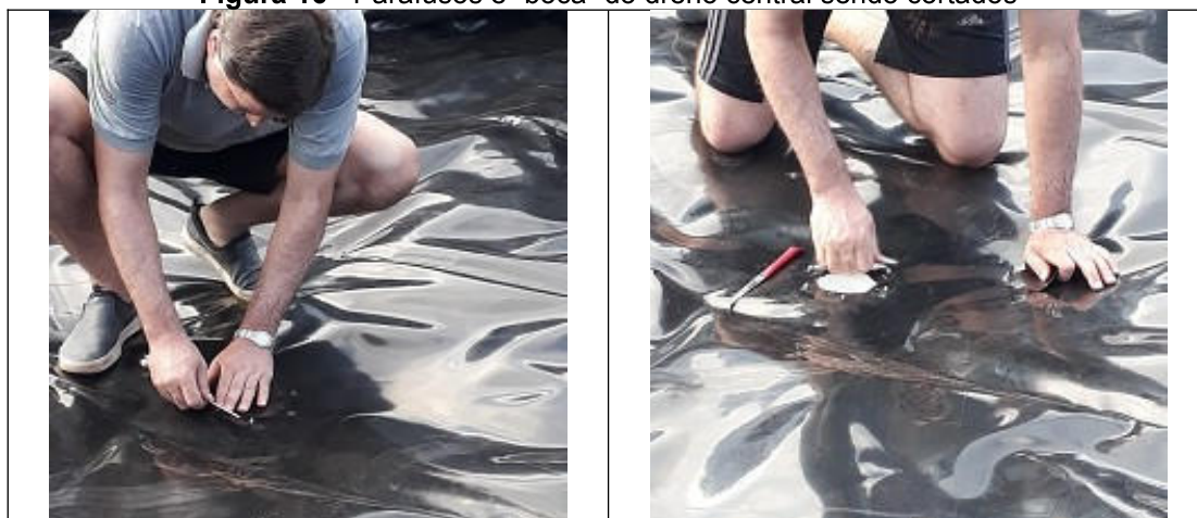
Figura 16 - Parafusos e “boca” do dreno central sendo cortados
