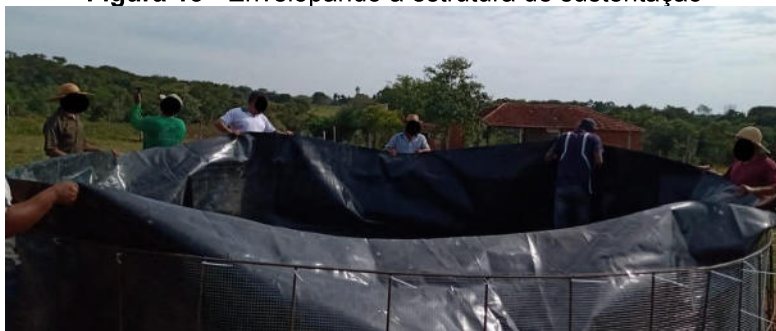
Figura 13 - Envelopando a estrutura de sustentação
