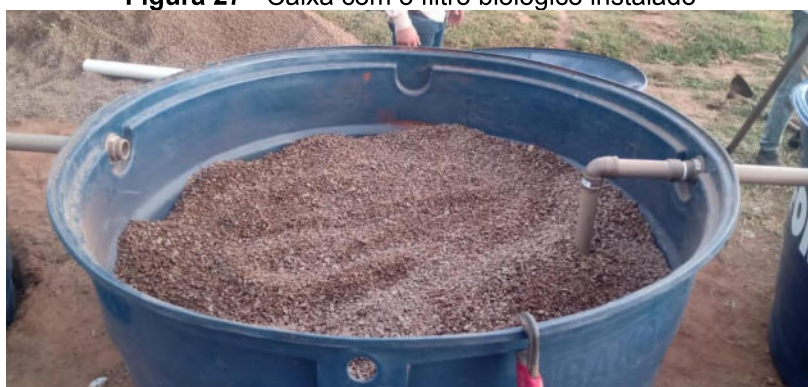
Figura 27 - Caixa com o filtro biológico instalado
