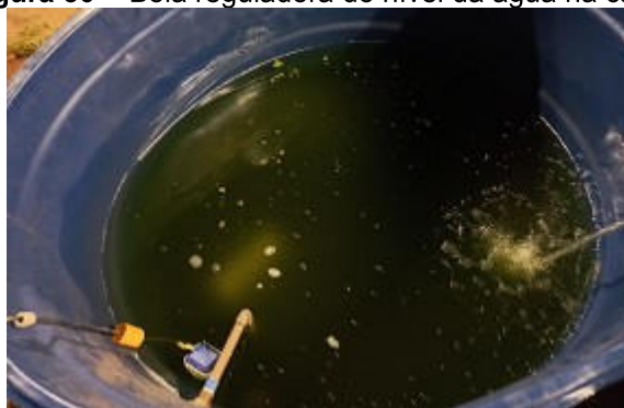
Figura 30 - Boia reguladora do nível da água na caixa
