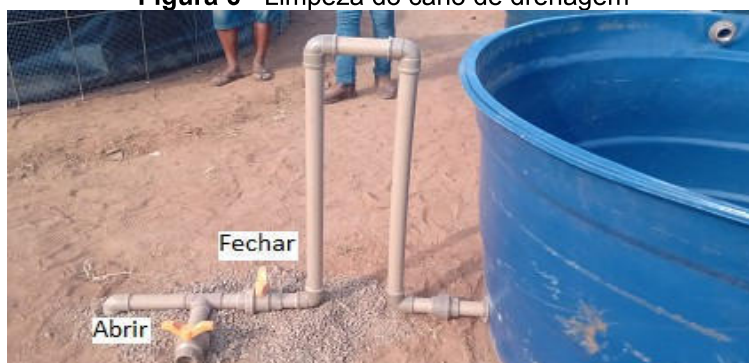
Figura 6 - Limpeza do cano de drenagem
