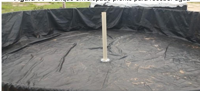
Figura 14 - Tanque envelopado pronto para receber água
