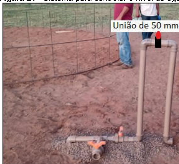
Figura 21 - Sistema para controlar o nível da água
