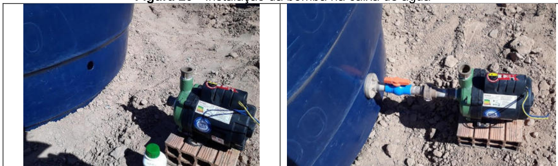
Figura 29 - Instalação da bomba na caixa de água
