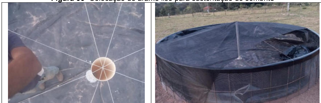
Figura 35- Colocação de arame liso para sustentação do sombrite
