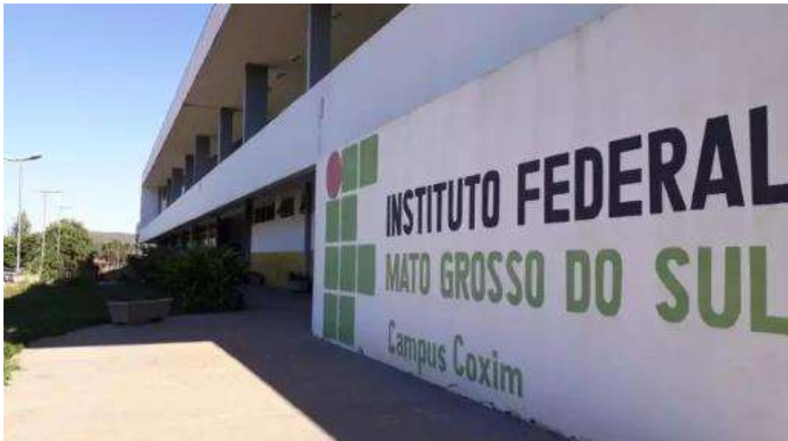
Figura 1 - Bloco de administração e biblioteca do IFMS - campus Coxim
